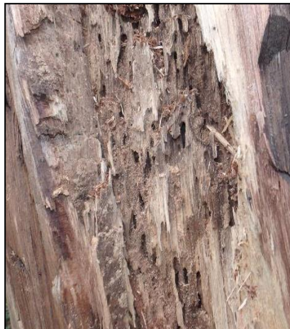
Bild 3: Stütze (Bongossi) Insektenbefall
