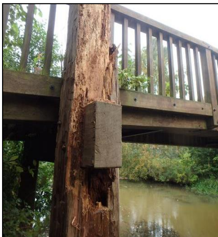
Bild 3: Stütze (Bongossi) Insektenbefall
