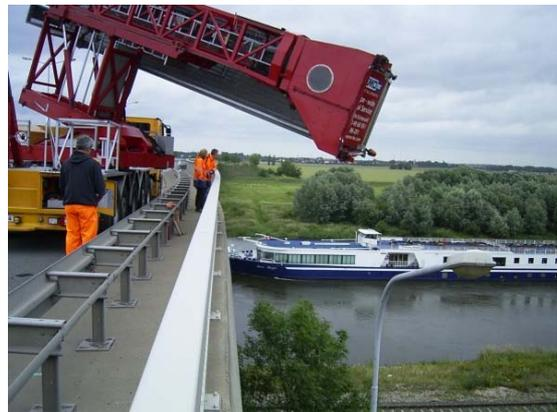
Die in vielen Fällen benötigte Zugangstechnik muss in Vorbereitung der Bauwerksprüfung geplant werden. Dazu gehört neben der Auswahl der Art der Zugangstechnik auch, dass sowohl der An- und Abtransport als auch der Einsatz vor Ort für alle Einsatzfälle gefahrfrei möglich ist.
