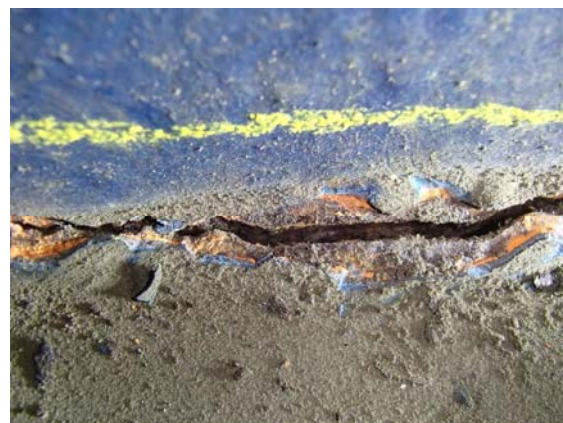
Bild 1.2: Schweißnaht des Anschlusspunktes
