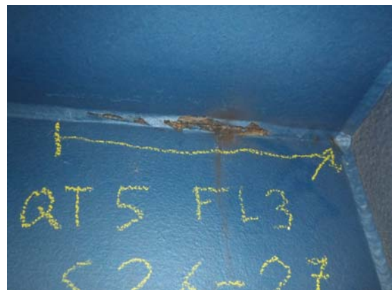
Bild 1.4: Schweißnahttriss Längsrippe-Deckblech
