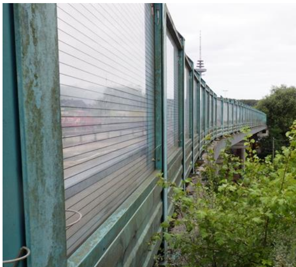
Pfosten-Wandelement-Konstruktion auf Brücke
